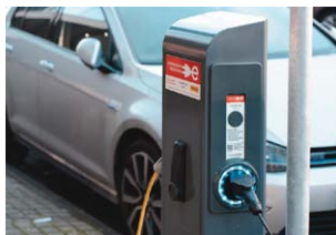
Monitoring EV polnilnih mest
